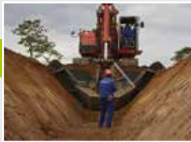
11. Aushub des Rohrgrabens
