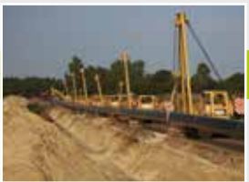
12. Absenken des Rohrstrangs
