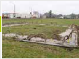
10. Installation und Inbetriebnahme der Wasserhaltung
