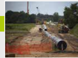
8. Rohrausfuhr auf die Trasse
