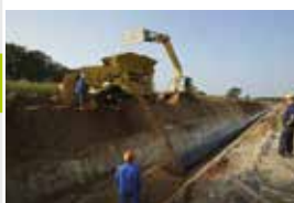
14. Verfüllen des Rohrgrabens
