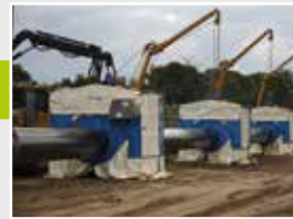
9. Vorbau: Verschweißen der Rohre zu einem Leitungsstrang in Schweißzelten
