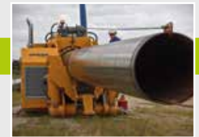
7. Biegen der Rohre
