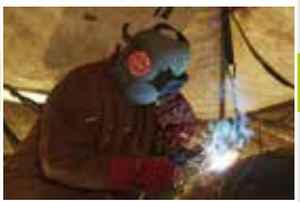
13. Verbindungsschweißen im Rohrstrang
