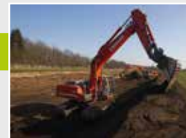
5. Abtrag des Oberbodens
