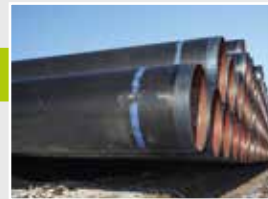
4. Rohrlagerplatz in Nähe der Leitungstrasse
