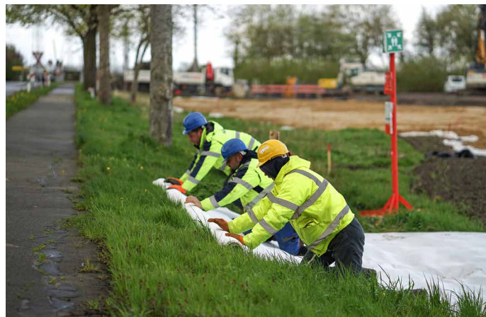
Vor Beginn der Arbeiten wurde zum Schutz des Bodens Geotextil verlegt.
