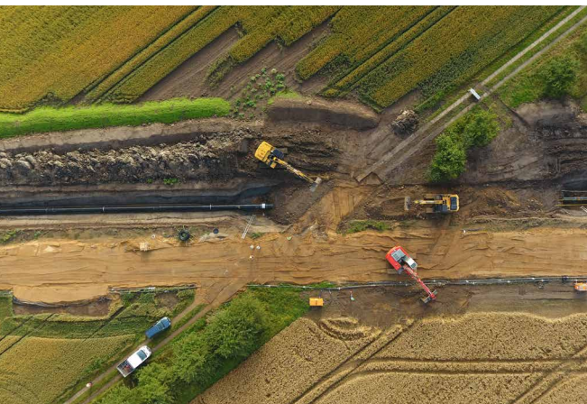
Bei der Rekultivierung ist der Rohrgraben geschlossen und die Leitung nicht mehr sichtbar.
